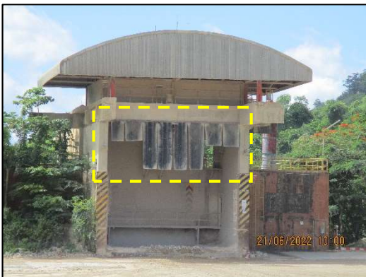
รูปที่ 2-15 ม่านรื้อและระบบสเปรย์น้ำบริเวณโรงไหม
